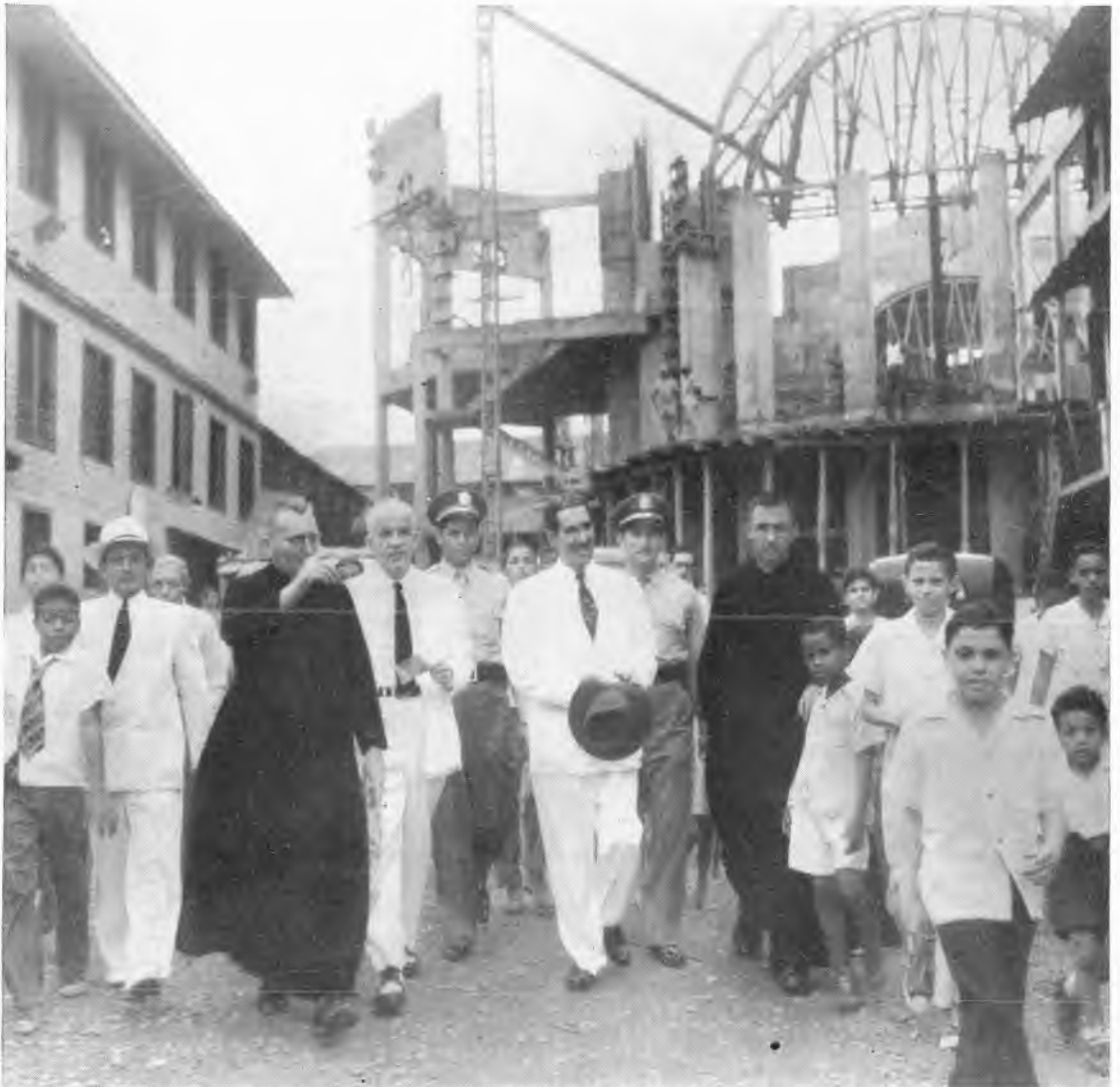
PANAMÀ - Il Presidente della Repubblica visita i lavori della chiesa in costruzione.
